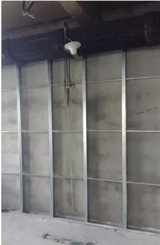
1、放样：如上图及现场实测尺寸进行放样，以两收边中心线与地面的交点弹出地轨中心线。应保证这四条线处在一个垂直面内，以保证以后安装之墙面的垂直。
