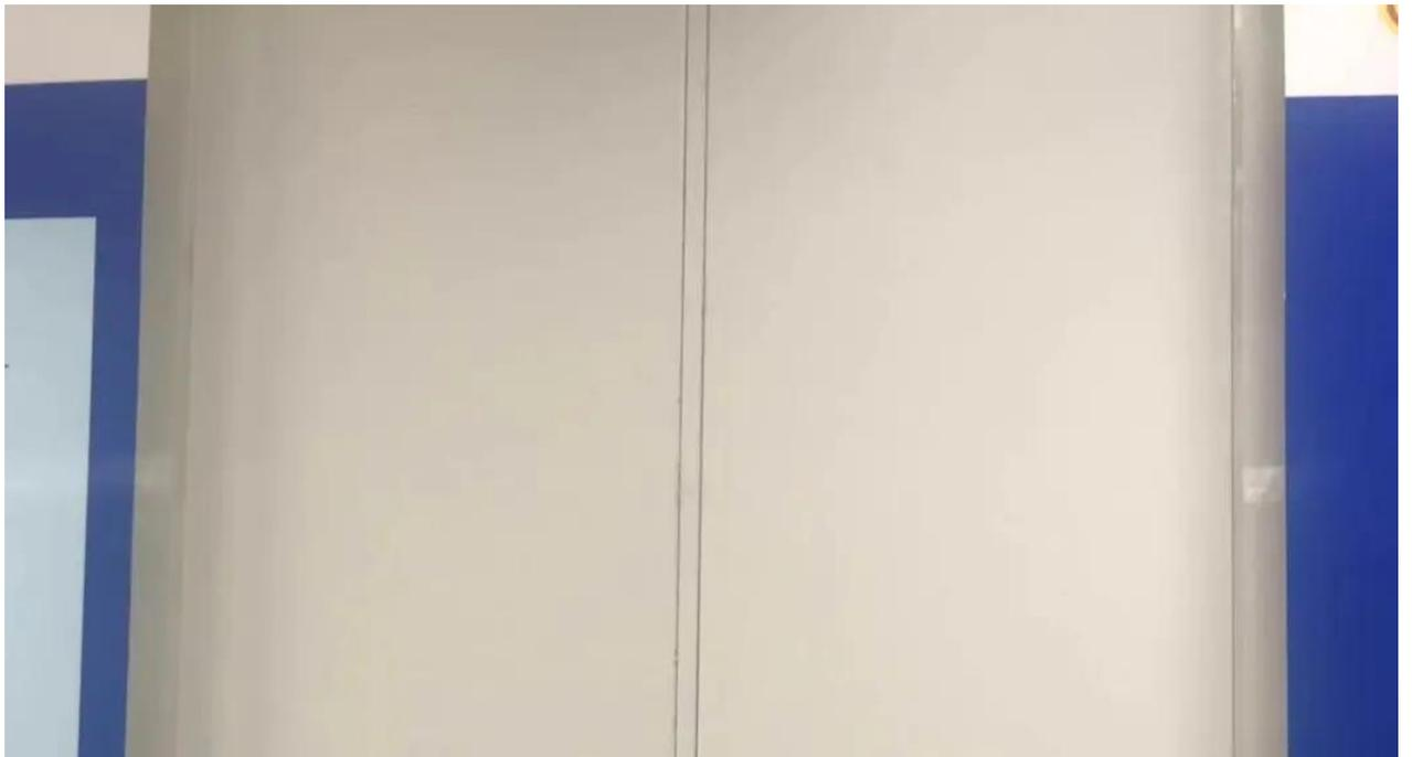
7、墙板：由一侧开始安装彩钢板，依次安装，相连板间距 12mm。隔板之间采用宽度 12mm 压条（如上图），标准单元墙板均可互换。
