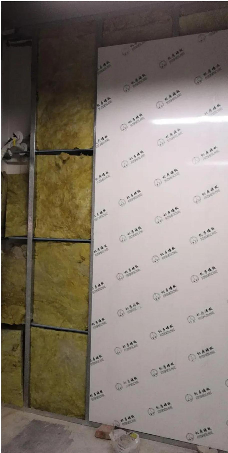
8.依次安装彩钢板,如遇到墙角或是柱子,整块板放置不下时(如上图),需精确测量好尺寸,在墙板上打好线,用无齿锯进行裁剪,裁剪后的缺口可以用阴角收边。
